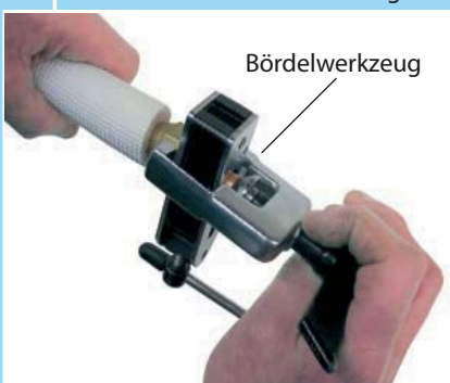
6 Bördeln der Kältemittelleitung
